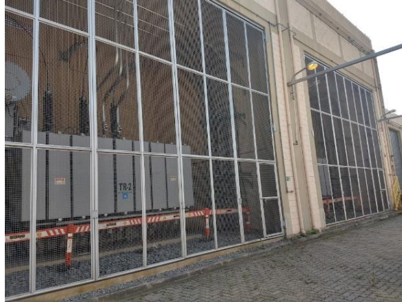
Figura 2 - Transformadores enclausurados.
